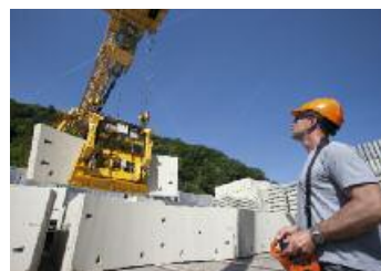
Die Vakuumhebeegeräte der DEVO-Tech AG kommen auch beim Bau des Belchen隧nells zum Einsatz.
